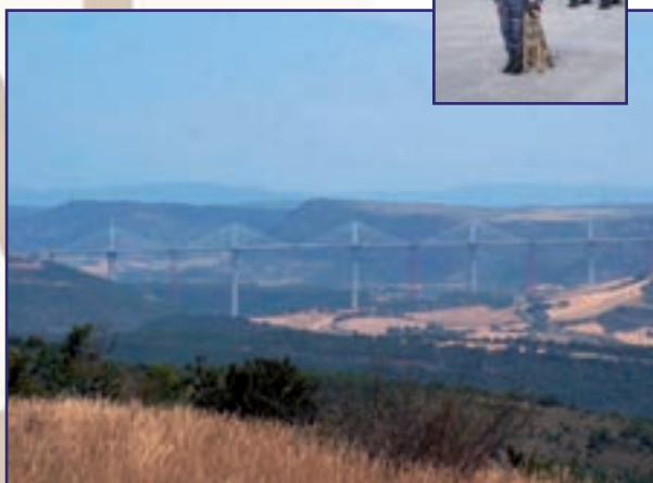
Viaduc de Millau
